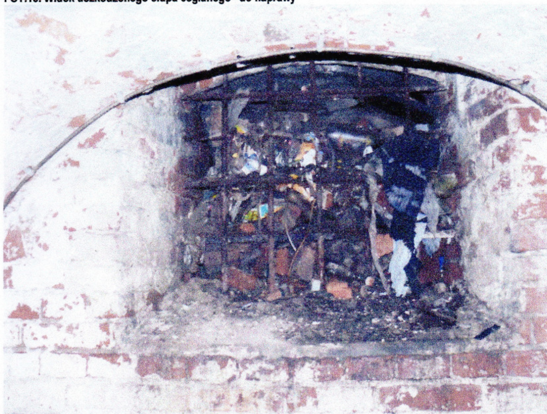
FOT.14. Widok zasypanego otworu okiennego piwnicy –do naprawy
