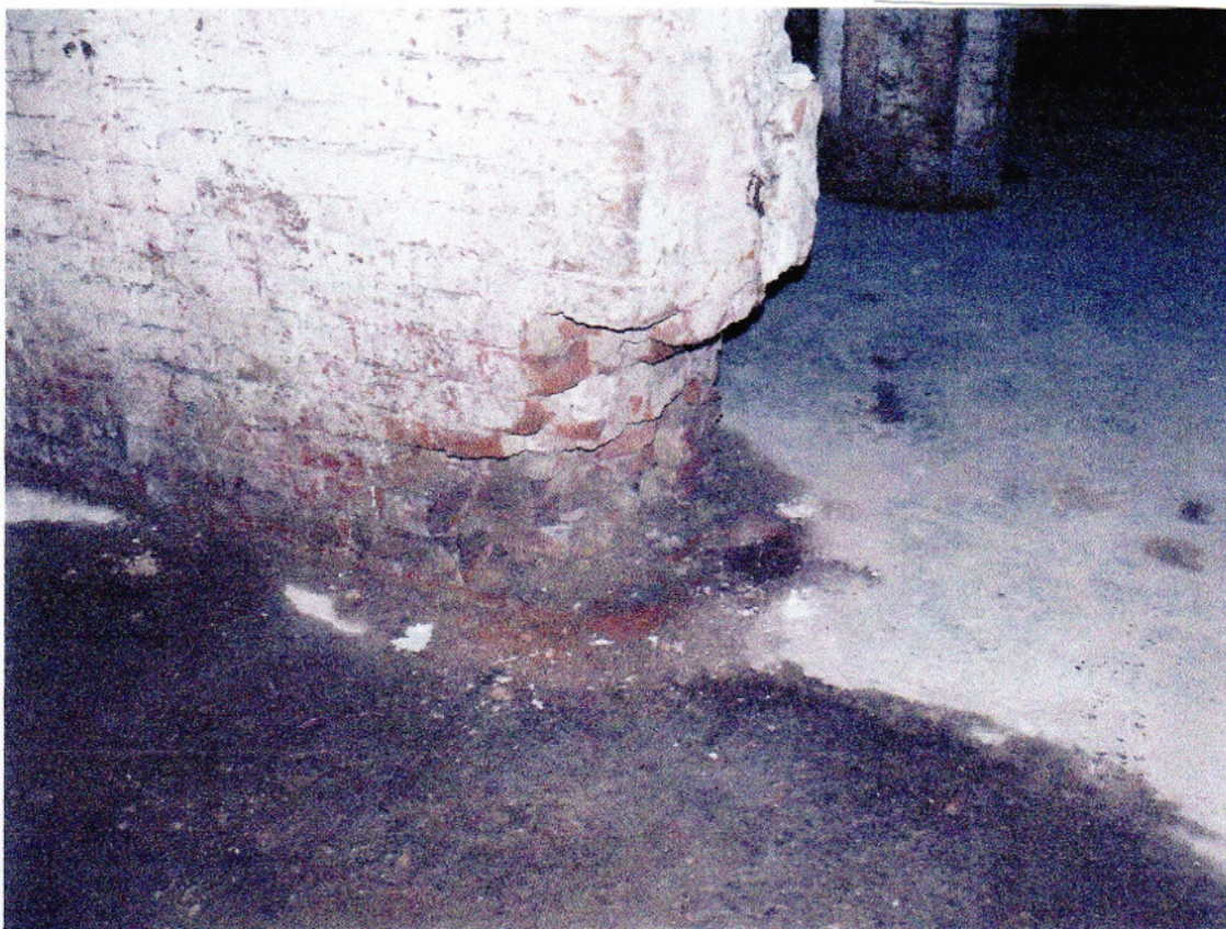
FOT.13. Widok uszkodzonego słupa ceglanego –do naprawy
