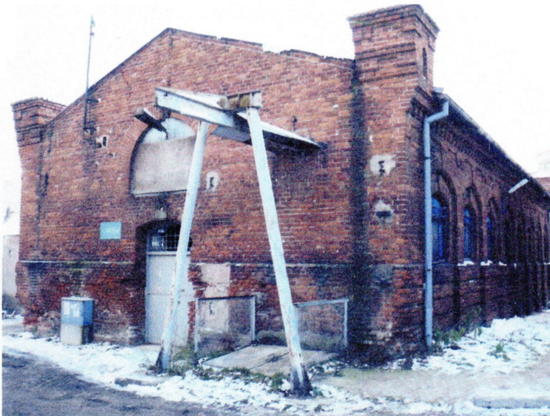
FOT.3. Widok elewacji szczytowej od strony posesji-widoczne zniszczenie cegieł w pasie przyziemia oraz zarysowanie ściany nad nadprożem okiennym-do naprawy
