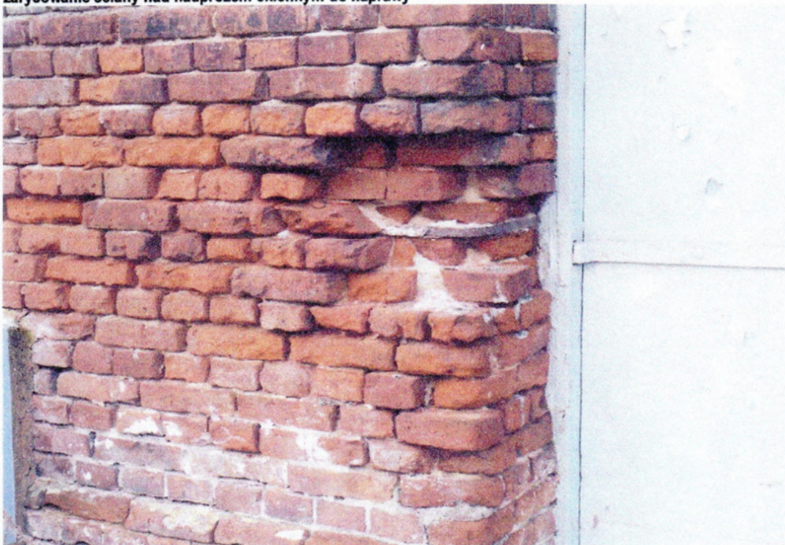
FOT.4. Widok skorodowanej warstwy cegły elewacyjnej i zaprawy-do wymiany
