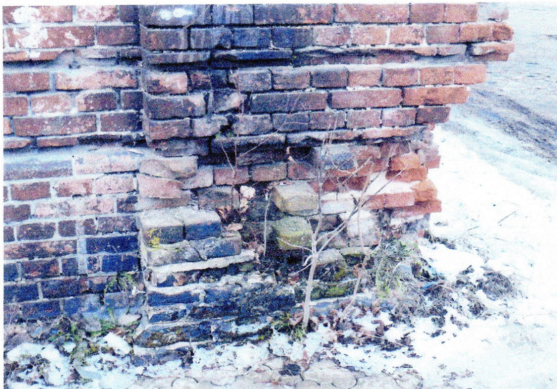
FOT.5. Widok uszkodzonego naroża ściany elewacyjnej –do naprawy
