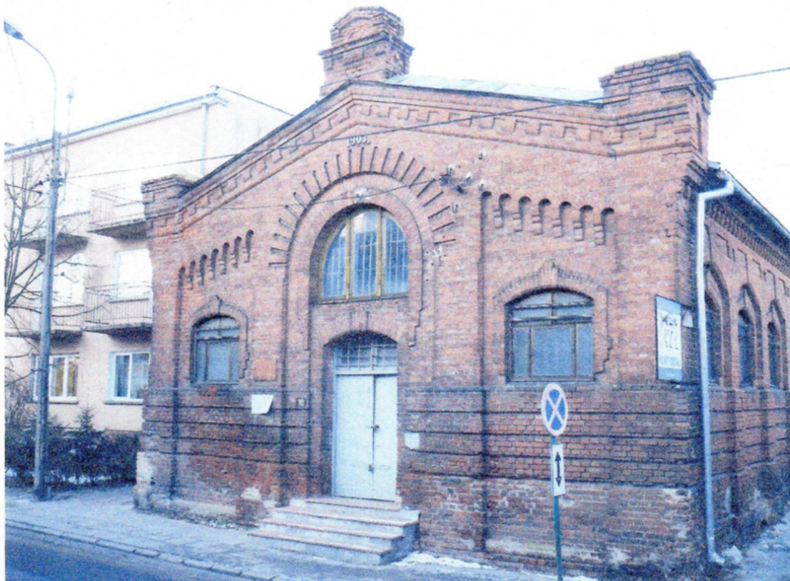
FOT.1. Widok elewacji frontowej budynku-widoczne zasolenie ścian do wysokości ca. 1,0m od terenu
