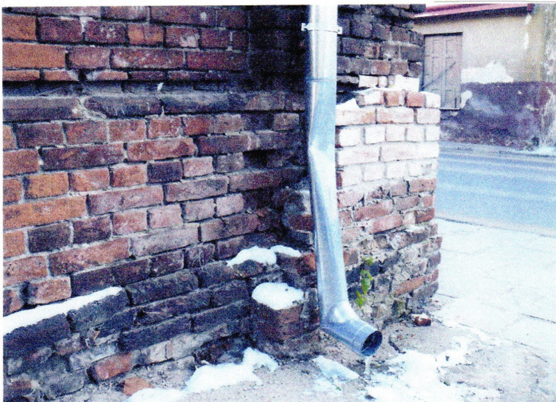
FOT.7. Widok uszkodzonego odwodnienia połaci dachowej oraz niestarannego wykonania naprawy uszkodzonego narożnika budynku. Widoczne zagrzybienie ściany przyziemia –do naprawy
